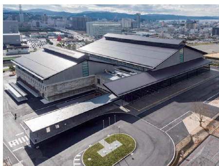
松江市総合体育館(島根県)
