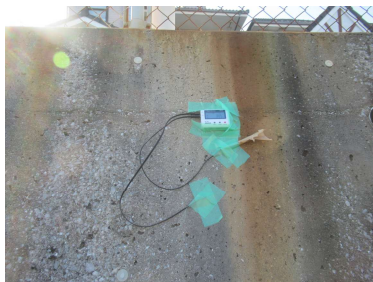
温度計測機器設置状況
