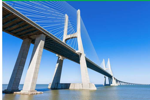
インフラの状態監視
