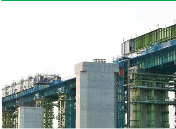
橋梁工事の安全管理
