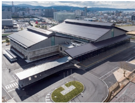
松江市総合体育館(島根県)
