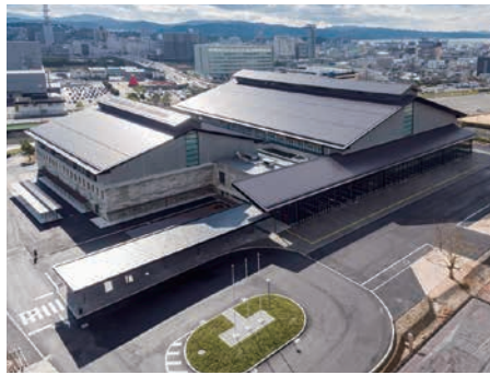
松江市総合体育館(島根県)
